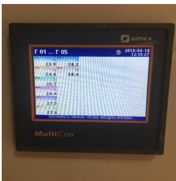
Figur 4.4: Äldre hallen. Resultatet visar att temperaturgradienten är 4,5°C dvs 0,64°C/m
